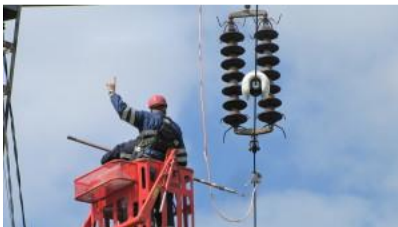
شکل ۴: نیاز به جرثقیل برای نصب تجهیزات مانیتورینگ خط انتقال بر روی خط و در حالت برق‌دار
